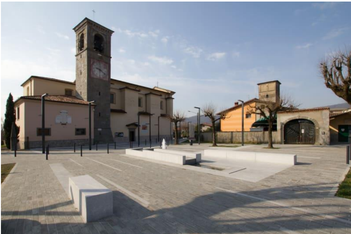
Esempio realizzativo di pavimentazione in pietra nel comune di Villongo
