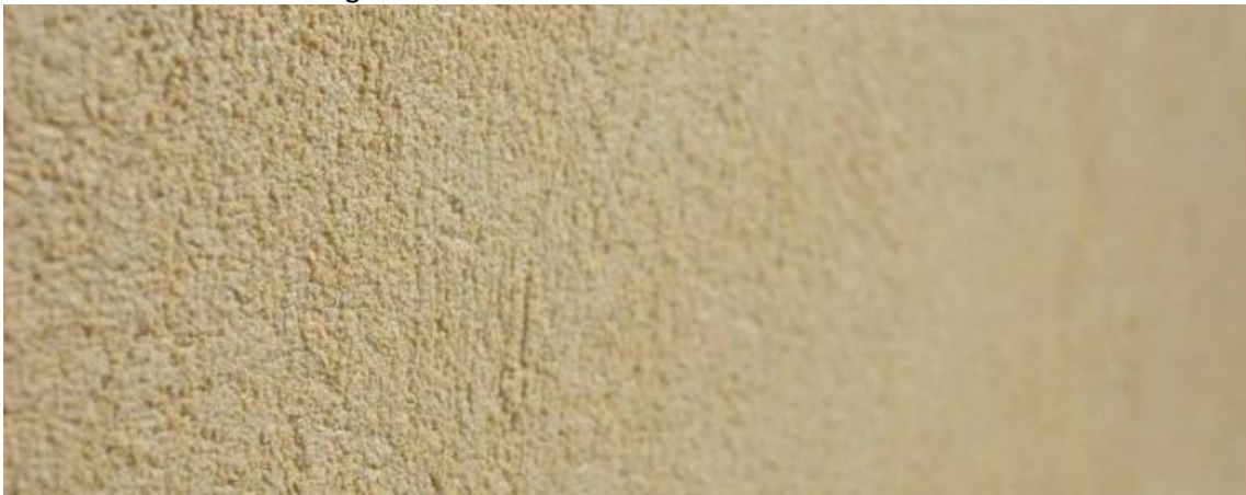
Intonaco a base di calce a grana fine
