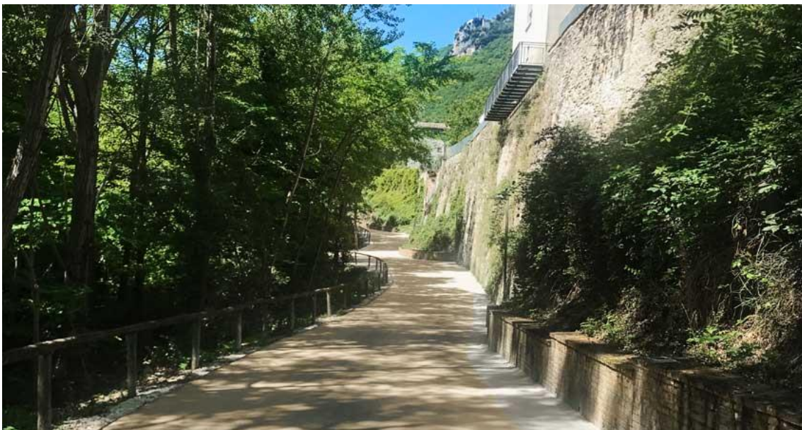
Esempio realizzativo di pavimentazione in asfalto ecologico colorato nel comune di Esanatoglia
