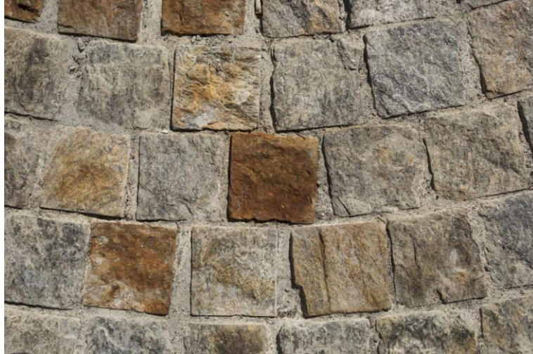
Esempio realizzativo di pavimentazione in pietra nel comune di Sonogno
