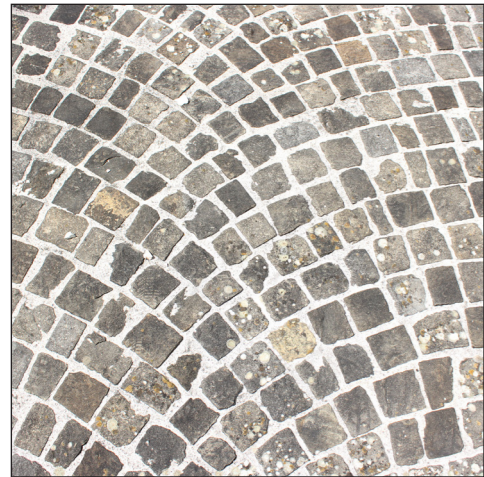
CUBETTI DI PORTIDO POSATI AD ARCO
